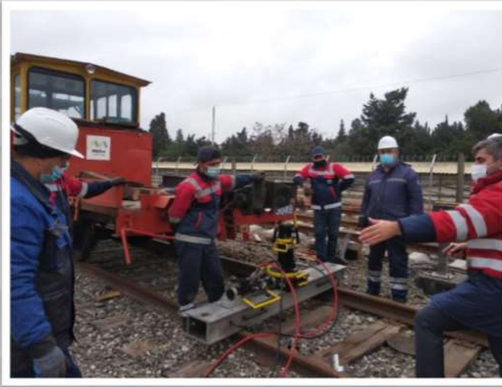
Relstdən çıxmış elektrik və təsərrüfat qatarının qaldırılması
